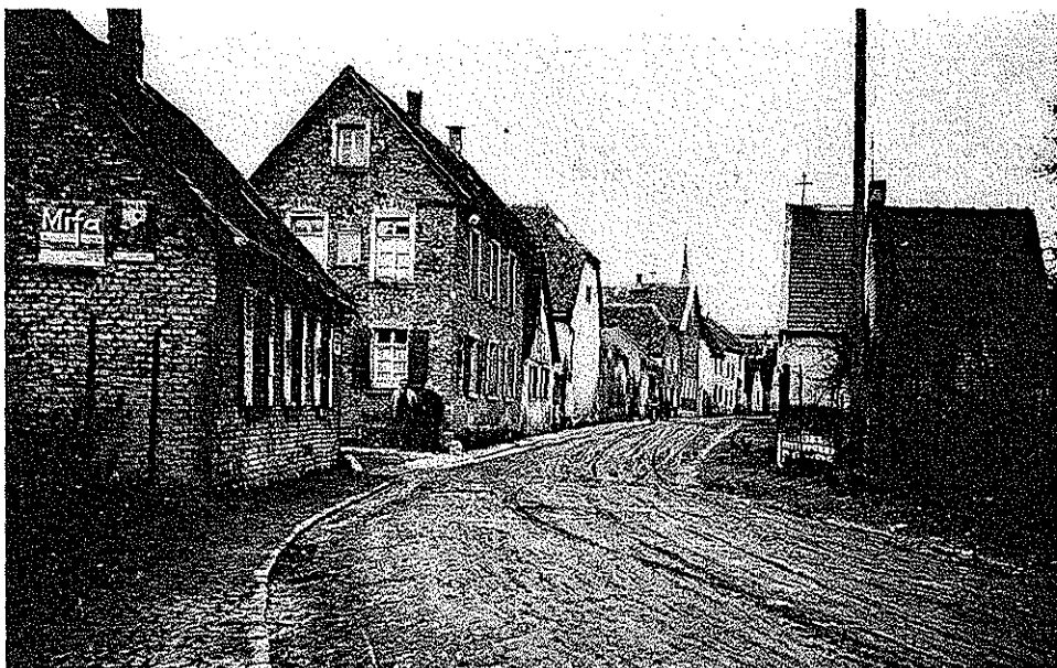
Die Töngesstraße 1928 vor der Kanalisation.
