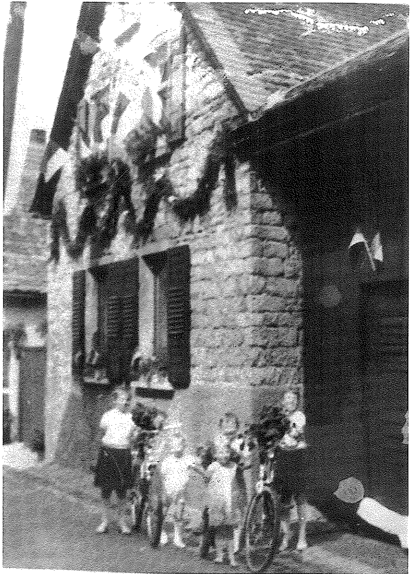
Haus von Markus Mayer in Erbe Siegfried Mayer, Kirchgasse.
